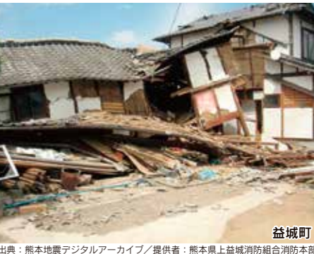
出典：熊本地震デジタルアーカイブ/提供者：熊本県上益城消防組合消防本部
