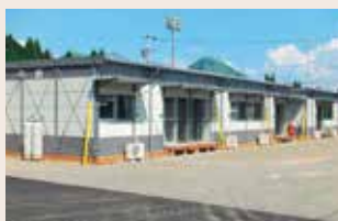
応急仮設住宅
