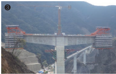
3. 施工ブロックを大型化し、ブロック数を減らしたことで作業効率が大幅に向上。橋桁の両端に見える超大型移動作業車で工事が行われた
