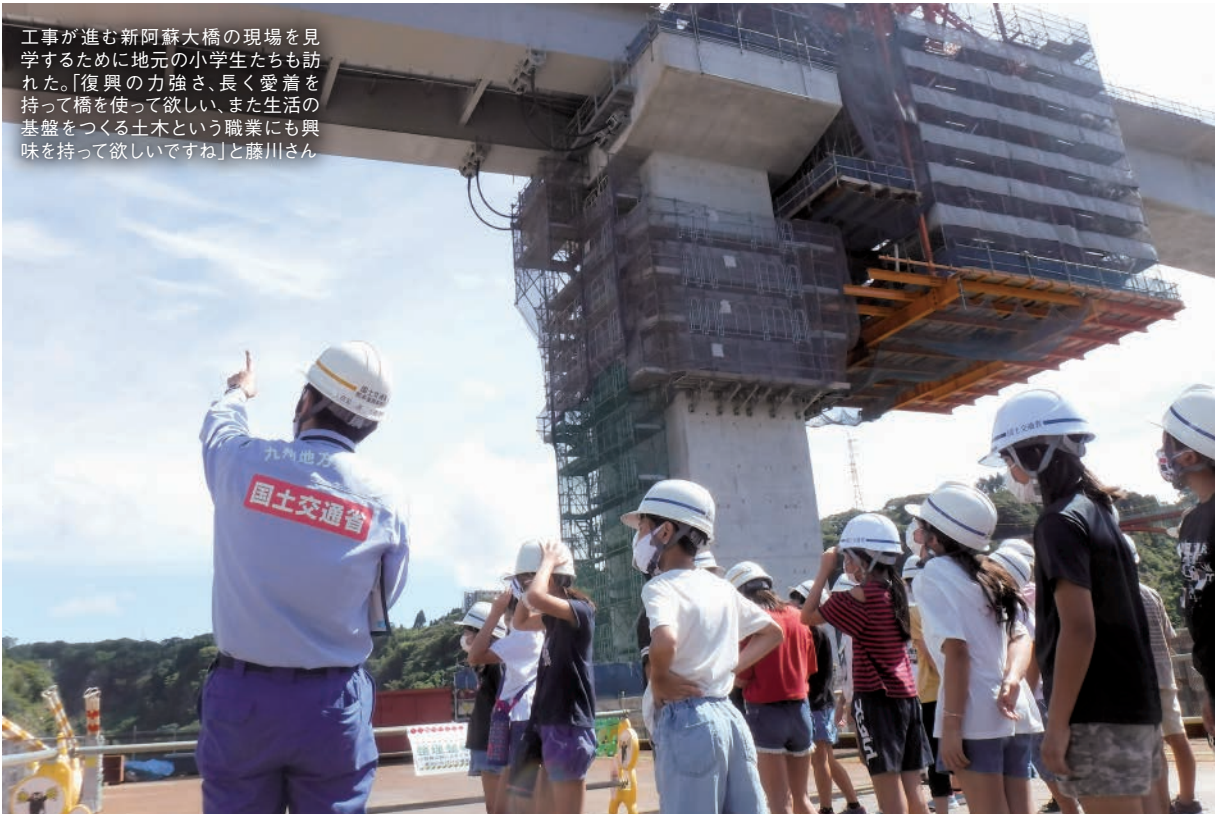
3. 施工ブロックを大型化し、ブロック数を減らしたことで作業効率が大幅に向上。橋桁の両端に見える超大型移動作業車で工事が行われた
