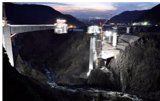
工事は24時間体制で行われることも。「多くの関係者の努力により計画通りに進めることができました」
