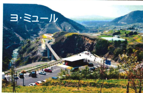
新阿蘇大橋全景
