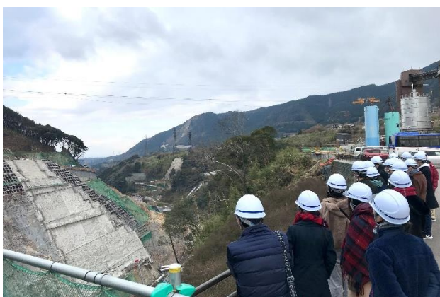
実際の工事現場を見学
