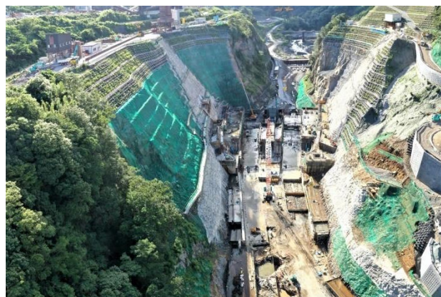
建設中の立野ダム(2023年完成予定)
