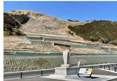
大規模斜面崩落
