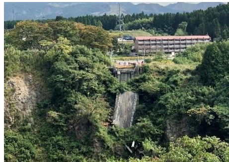
崩落した旧阿蘇大橋の橋桁
